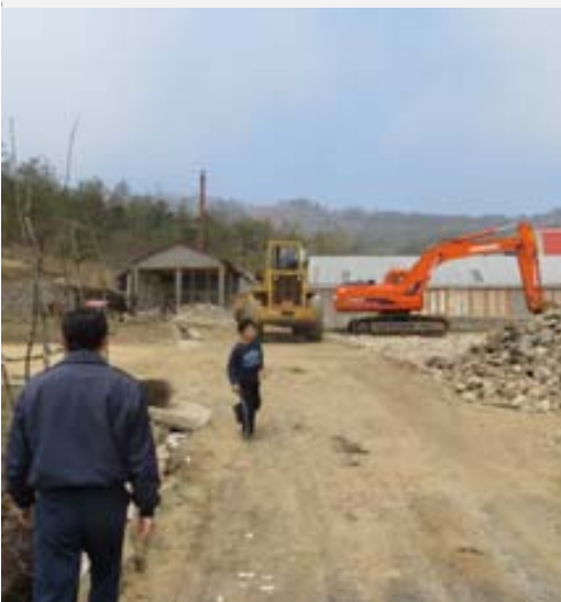
Neubau einer Halle zur Sojaölproduktion
